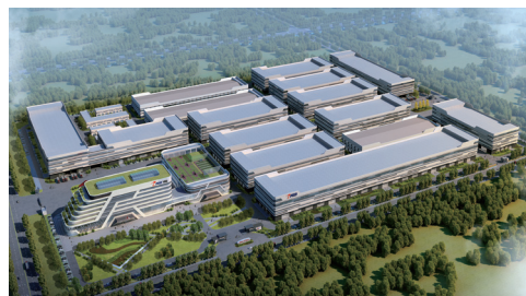
飞荣达科技(江苏)高导材料产业园二期(在建中)
