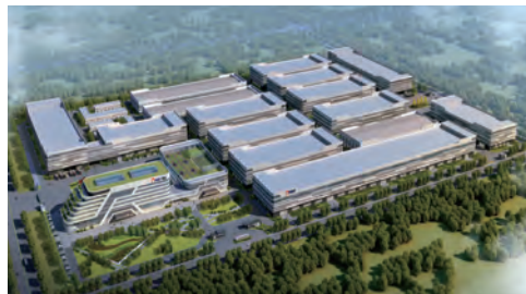
飞荣达科技(江苏)高导材料产业园二期(在建中)
